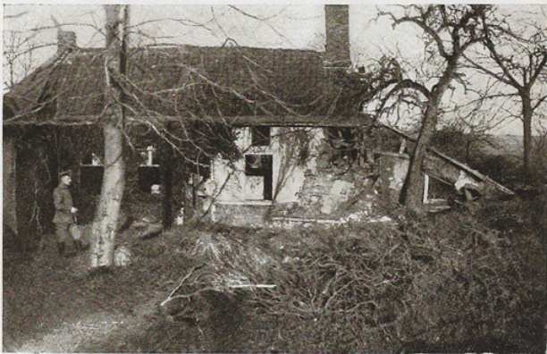
Grandcourt. Durch franzöf. Artilleriefeuer zerstörtes Haus
