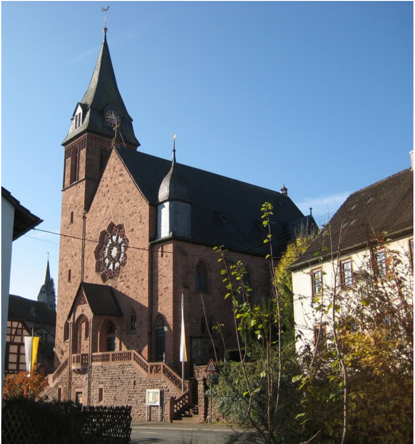
Pfarrkirche „St. Laurentius“ nach der großen Renovierung. - Foto 11/2013.
